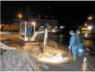
In der Dunkelheit machten sich Montagetrupps noch am Samstagabend an die Arbeit, um die lecken Stellen zu reparieren. Foto: (Uwe Renners)
